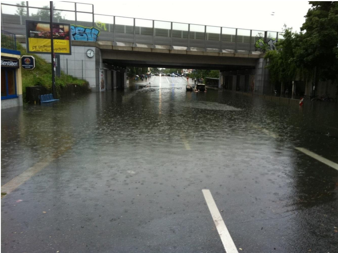
ABBILDUNG 22: ÜBERFLUTETE UNTERFÜHRUNG (FOTO: STADTENTWÄSSERUNG MÜNCHEN)
