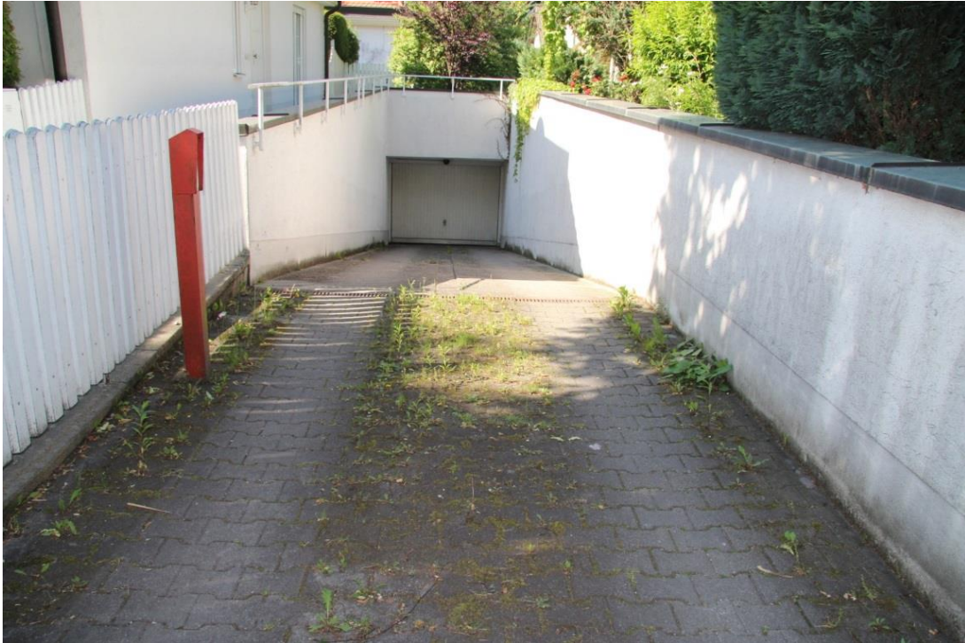
ABBILDUNG 47: GEFAHRENSTELLE TIEFGARAGENZUFAHRT (FOTO: GÜNTHERT 2015)
